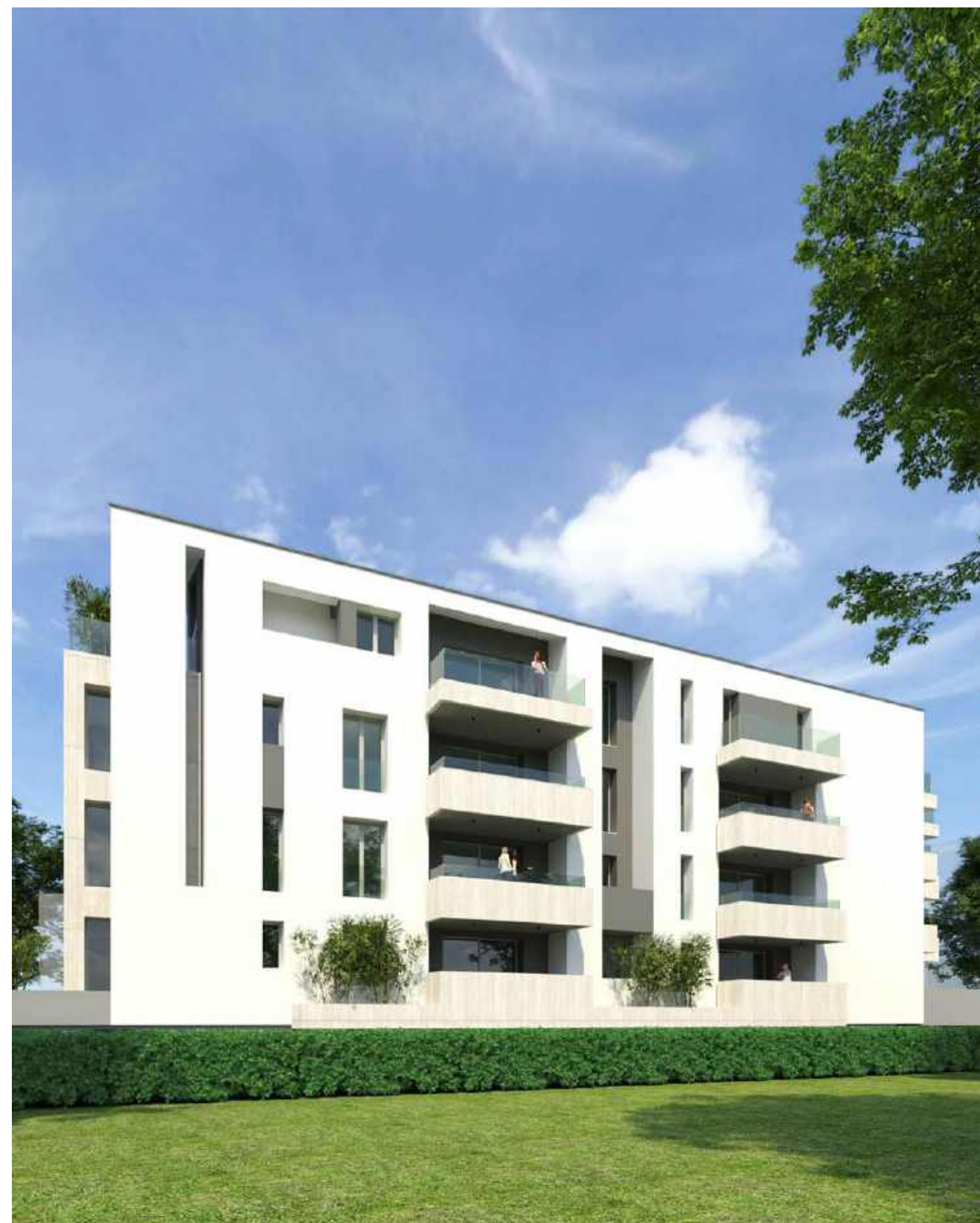
VISTA PALAZZINA FRONTE SUD
