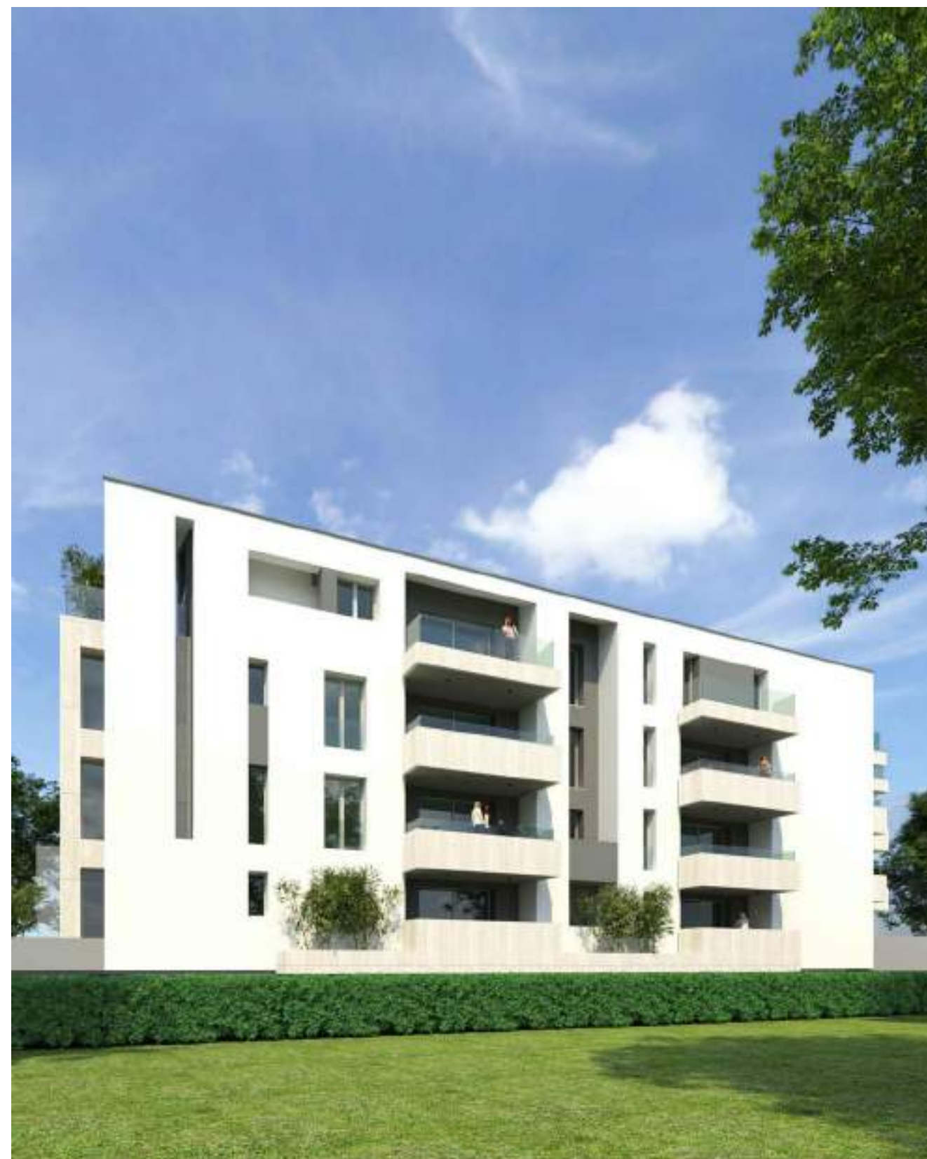
VISTA PALAZZINA FRONTE SUD
