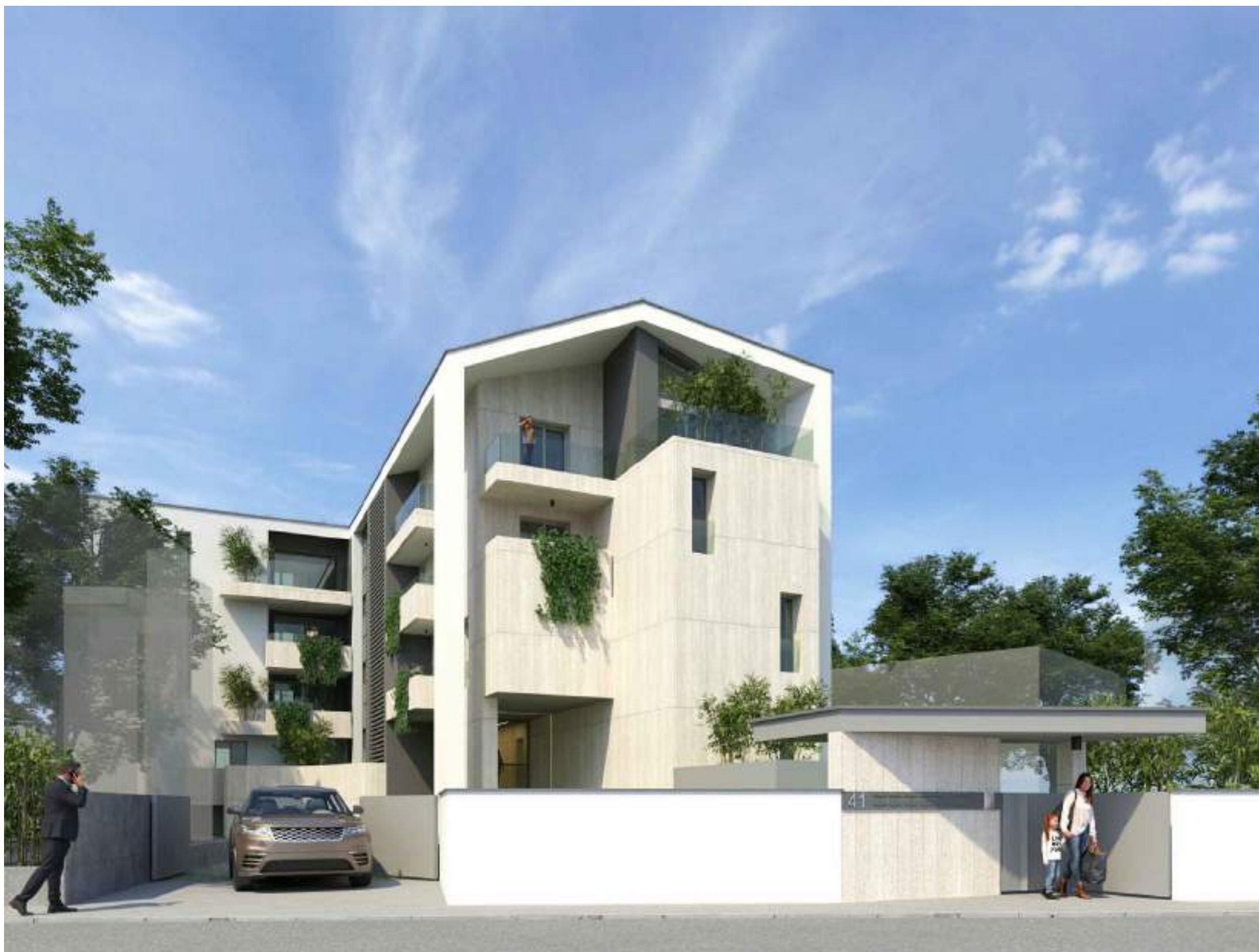
VISTA PALAZZINA VIA TRIESTE
